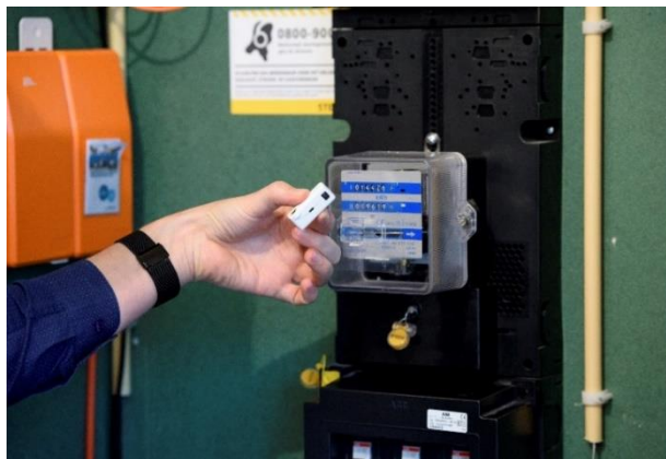
B. Klik de sensor uit de plastic sensorhouder. De houder blijft op de energiemeters bevestigd.
