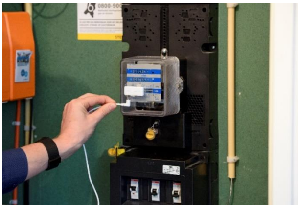
A. Maak de kabel los van de sensor.
