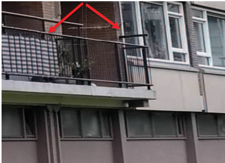
Figuur 4.1 Situatie balkons cluster 3111
