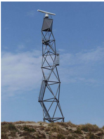
Figuur 8 - Radarpost Kust Zandvoort met een hoogte van 50m
